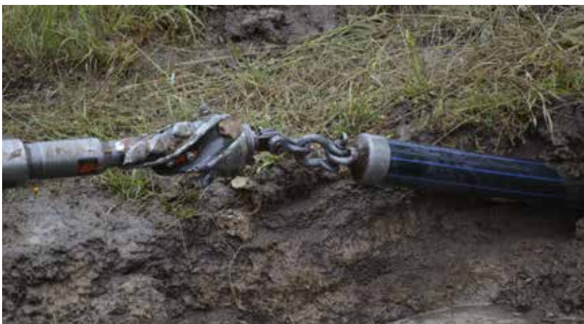
Trinkwasserleitung mit Kennstreifen d 125 mm, SDR 11 Drinking water pipe with strips d 125 mm, SDR 11
