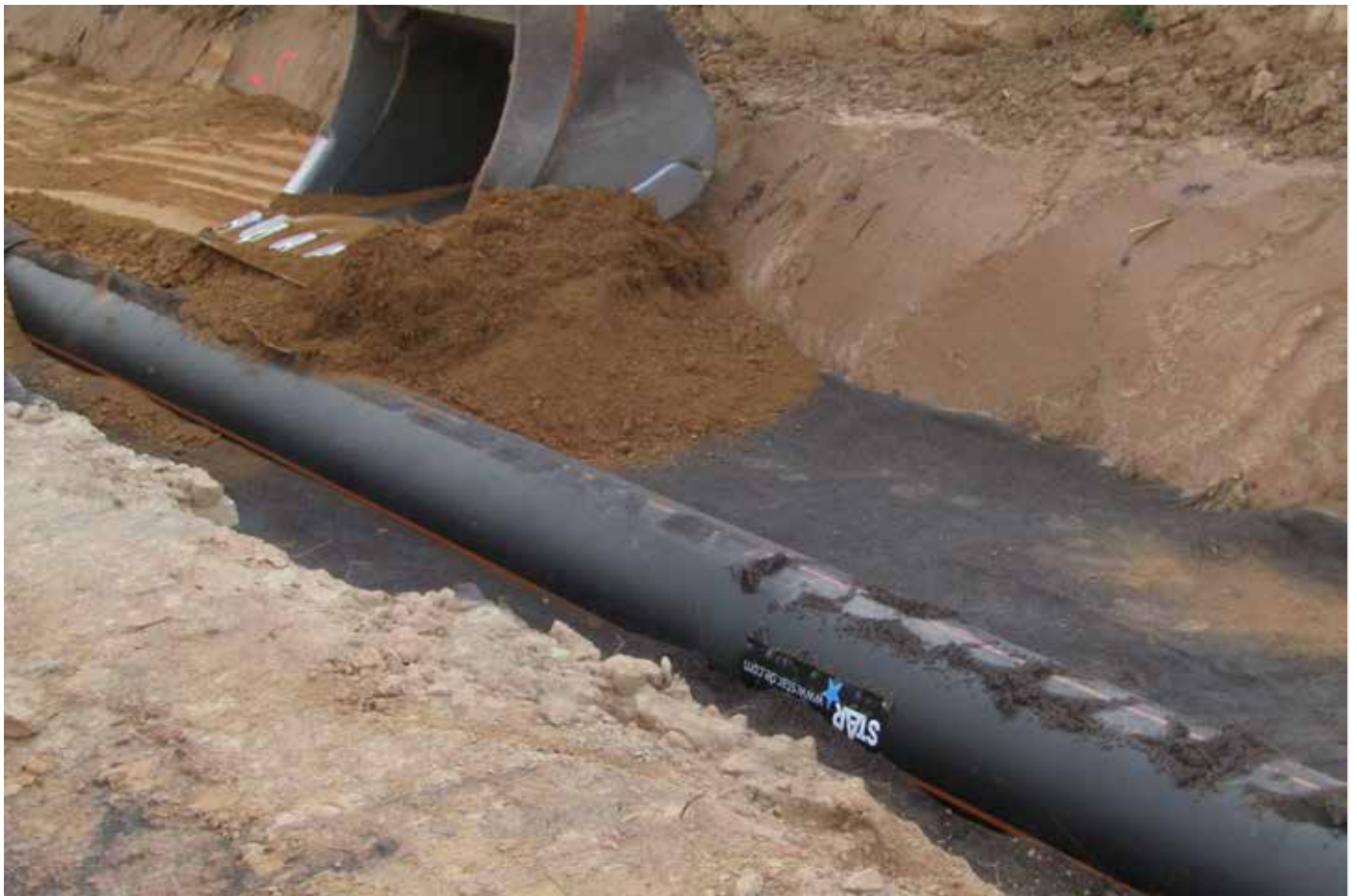
Abwasserdruckleitung d 560 mm, SDR 17 Waste water pressure pipe d 560 mm, SDR 17
